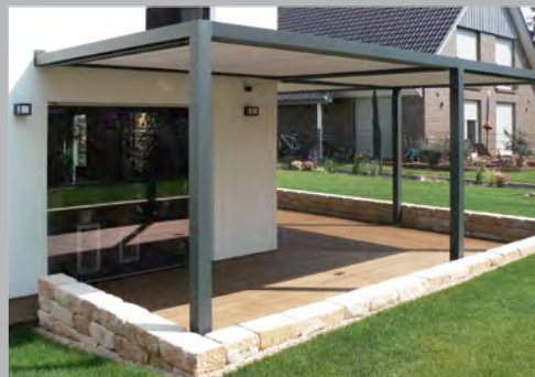
Wandbefestigung mit Stützen
