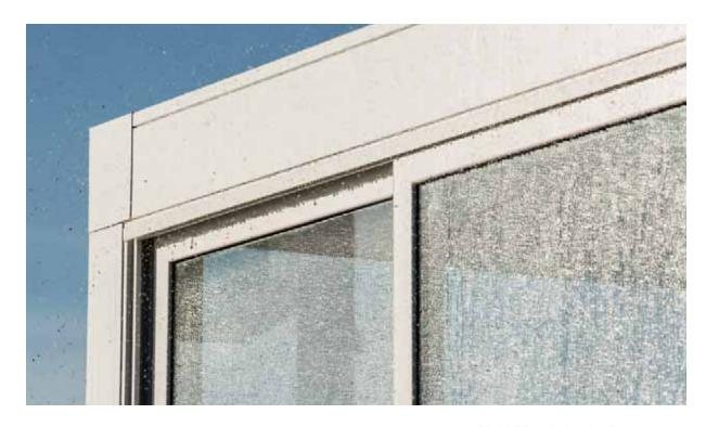
Die bioklimatischen Lauben Opera und Vision wurden auf einer Wasserundurchlässigkeitsprüfung (System mit Lamellen, Traufen und Ablässe) durch die Techniker des Istituto Giordano unterzogen (Probebericht Nr. 319934).
